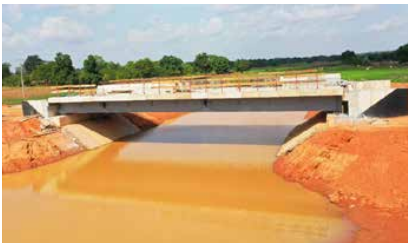
Le Pont de Napié
