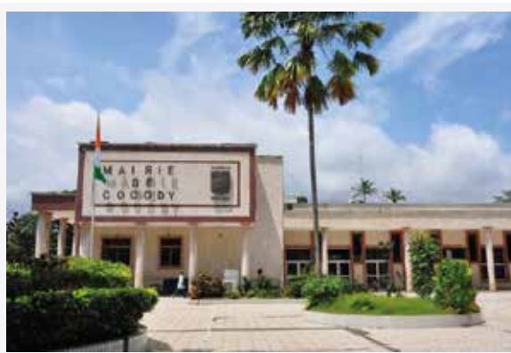
Réhabilitation des locaux de la Mairie de Cocody
