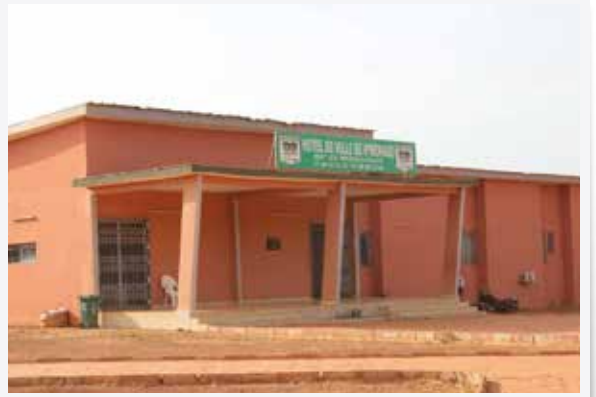
Réhabilitation des locaux de la Mairie de M'bengué
