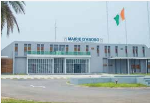
Réhabilitation des locaux de la Mairie d'Abobo
