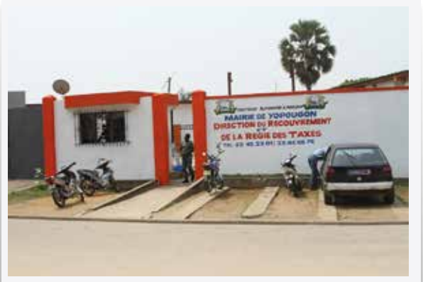
Réhabilitation des locaux de la Mairie de Yopougon
