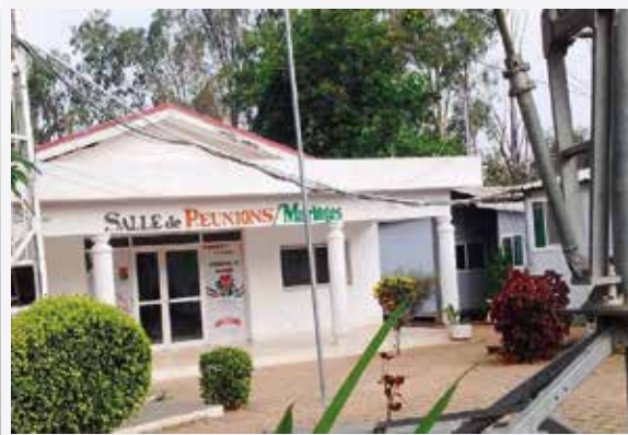
Réhabilitation des locaux de la Mairie de Bouaké
