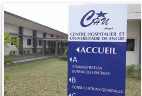
Rénovation des locaux du CHU d'Angré
