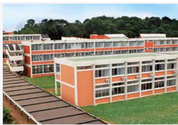
Rénovation des locaux de l'Université FHB de Cocody
