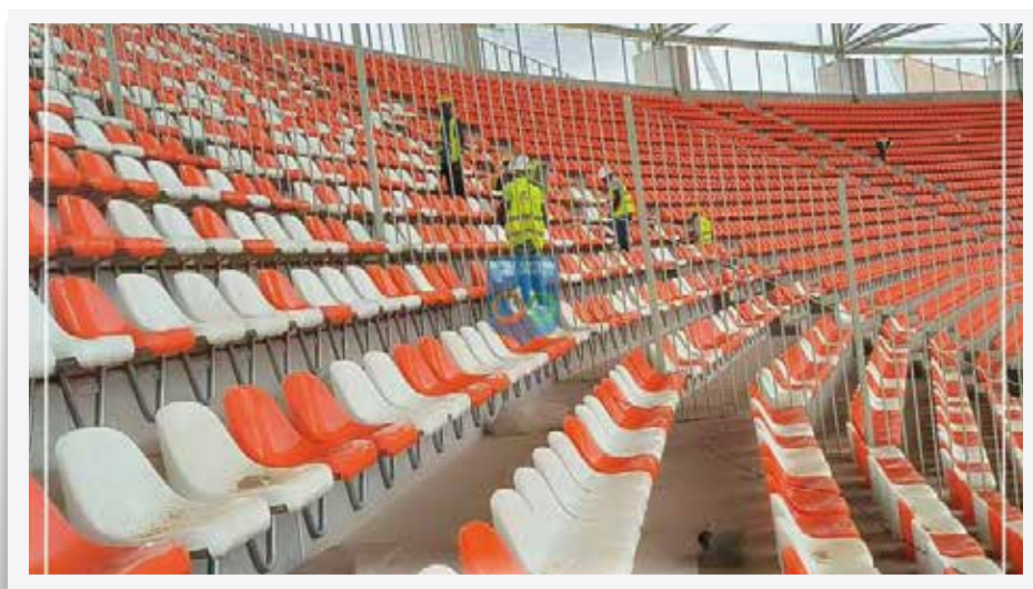
Construction des infrastructures sportives par l'ONS
